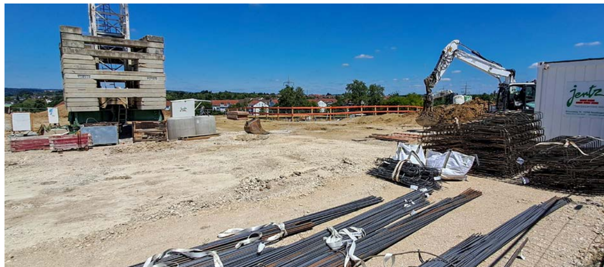
Bagger rollen und schweres Gerät ist im Einsatz: Auf dem Konversionsgelände in Reutlingen-Rappertshofen entsteht aktuell das neue Quartier.Wohn.Haus (QWH).
