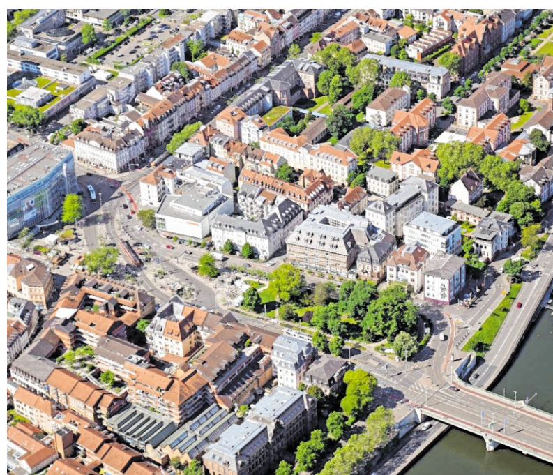
Ein Blick auf den Heidelberger Bismarckplatz und die Theodor-Heuss-Brücke (rechts im Bild). Bald starten dort die Gleisarbeiten. BILD: BERNHARD ZINKE
