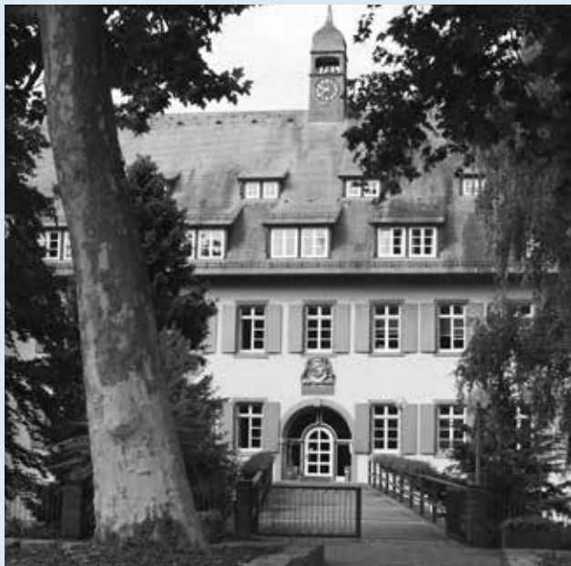
Das ehemalige Wasserschloss bietet ...
